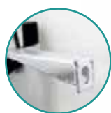
Fissaggio della struttura al muro
